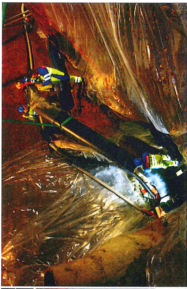
Baustelle Wissensteinfeld, Verlegung der Wasserleitung (Durchmesser 500 mm) Derendingen – Subingen – äusseres Wasseramt
