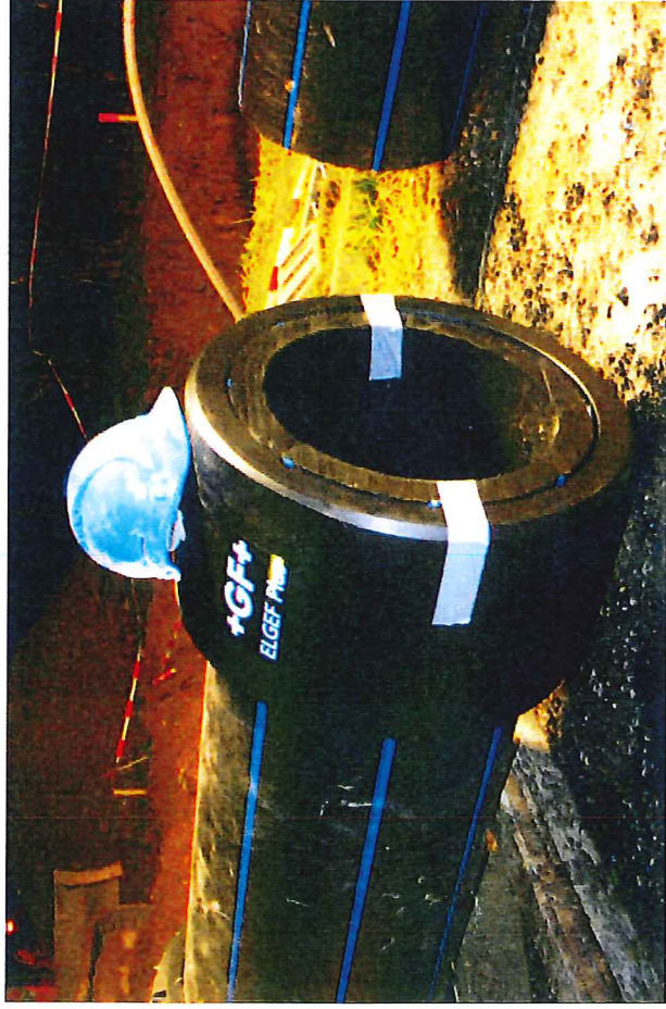
Baustelle Wissensteinfeld, Verlegung der Wasserleitung (Durchmesser 500 mm) Derendingen – Subingen – äusseres Wasseramt
