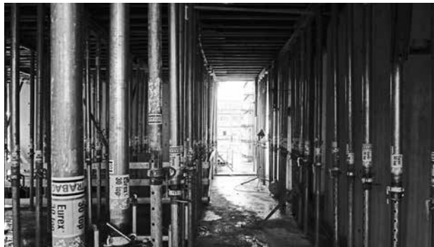
Eine Anzahl von Deckenstützen zum Betonieren der Decke über dem Haupteingang der neuen Schule
