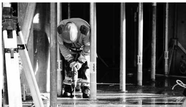
Arbeiter vom Gewerk Baumeister
