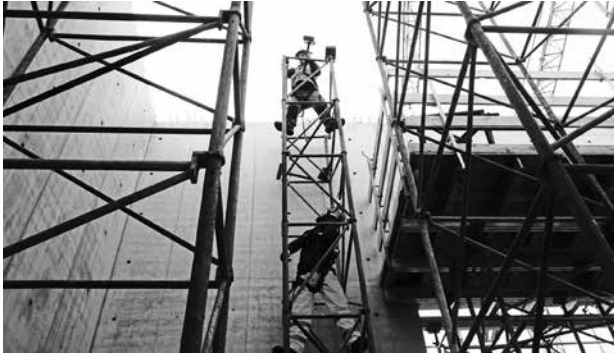
Facharbeiter beim Aufstellen des Modulgerüsts im Bereich der Bühne
