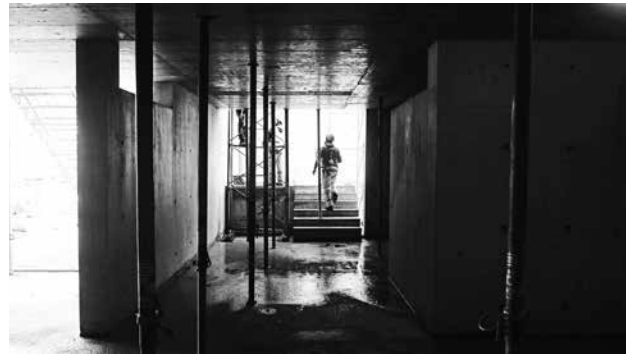
Treppe in den Bühnenbereich
