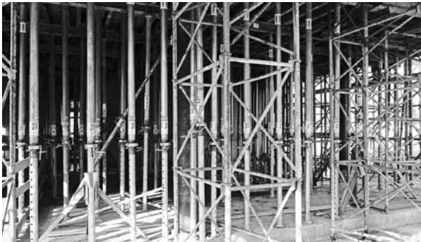
Deckenstützen zum Betonieren der Decke über dem Haupteingang der neuen Schule
